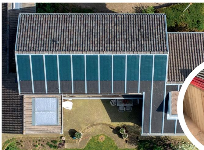
**DIE NACH WESTEN GENEIGTE DACHFLÄCHE** wird komplett für Solarenergie genutzt. Der obere, blaue Teil besteht aus PVT-Kollektoren, die Wärme und Strom produzieren, im unteren Teil bilden rein thermische Elemente die Dachhaut.
