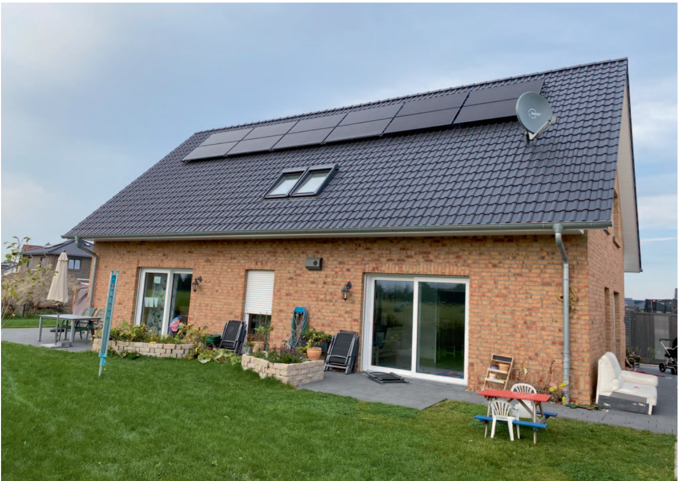
Das Viebrockhaus im niedersächsischen Harsefeld heizt und kühlt eine Wärmepumpe, die über ein PVT-Kollektorfeld auf dem Dach die Umgebungs- und Strahlungswärme der Sonne nutzt.
