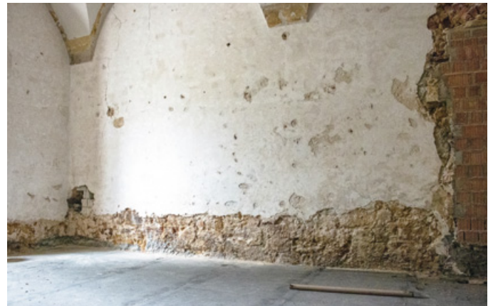
Mit Isolier- und Entfeuchtungsputzen auf Naturkalkbasis erübrigt sich ein aufwändiger Untergrundaussgleich. Sie schützen auch vor Salzausblühungen und Schimmel.
