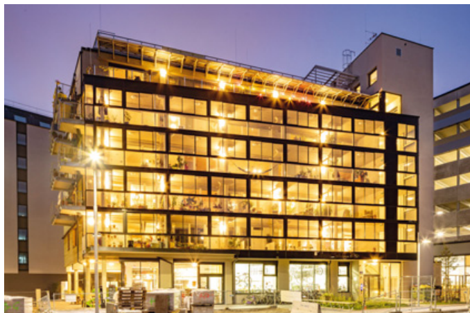
Der Eigenverbrauch des von 39 m 2 halbdurchsichtiger Photovoltaik produzierten Stroms liegt bei etwa 70%. Foto: Hannah Mayr
