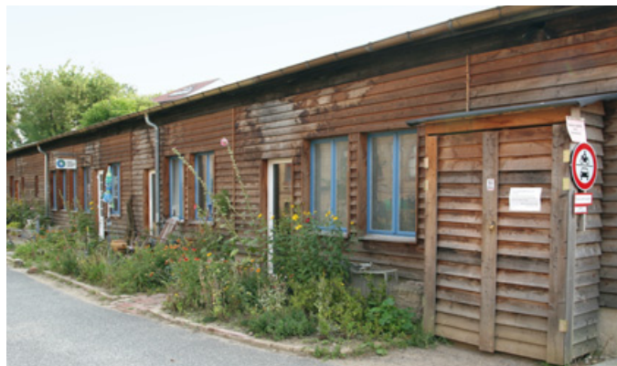
Halle 36 wurde außen gedämmt und beherbergt heute zwei Vereine mit verschiedenen Werkstätten und Räumen. Foto: Achim Pilz
