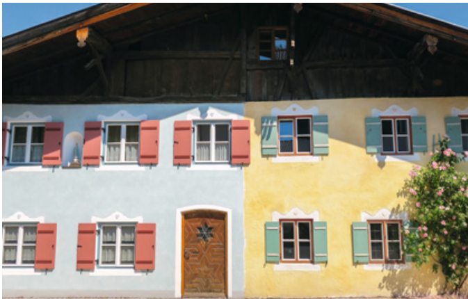
Deckputze wie Bio-Kalkputze oder Farbanstriche mit Kalkfarbe können nach wenigen Tagen aufgetragen werden. Alle Fotos: Haga
