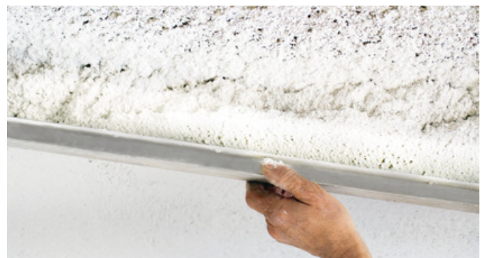
Direkt nach dem Aufspritzen wird der Dämmputz mit einer Abziehleiste glattgezogen.
