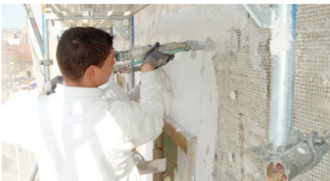
Maschinelles Aufbringen des Sanierputzes, der innen und außen einsetzbar ist.
