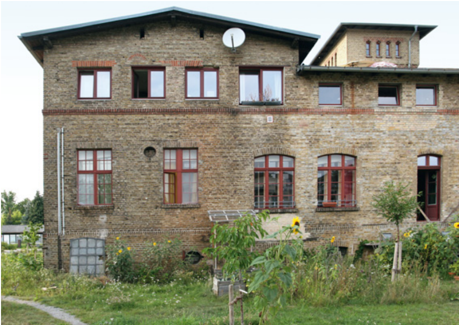
Südseite der nun innen mineralisch gedämmten Fabrik. Auch die Leibungen der zu Kastenfenstern ertüchtigten Bestandsfenster wurden gedämmt. Foto: Achim Pilz
